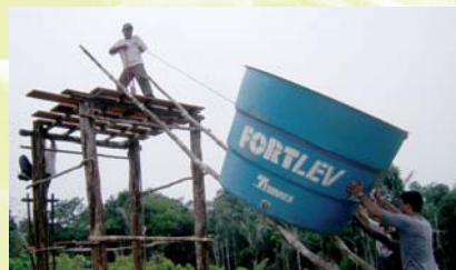
Instal·lació d'infraestructures hidràuliques pels cooperants de la Universitat Rovira i Virgili a l'Amazònia brasilera. URV Solidària 2004.
